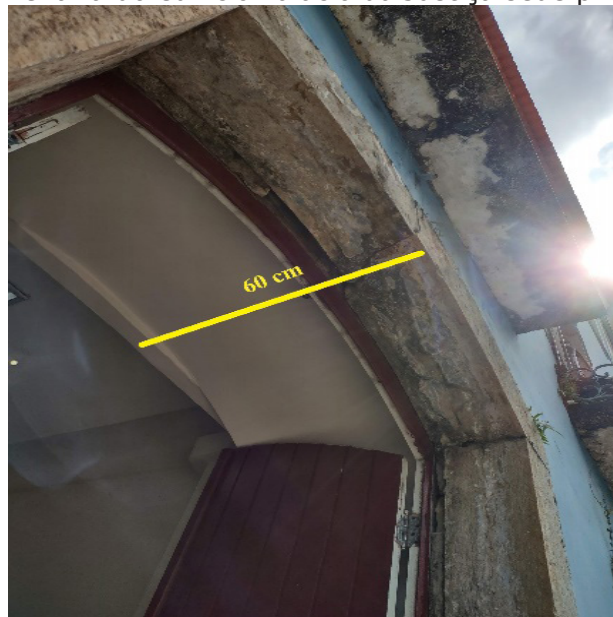
Figura 30 — Alvenaria do edifício Palácio da Justiça sede principal do TJ-MA
