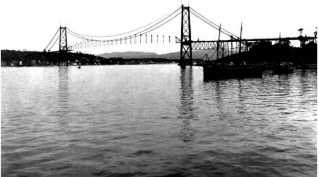
Figura 29. Ponte Hercílio Luz em construção (1924)
