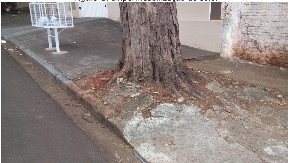
Figura 1: Impermeabilização do solo.
