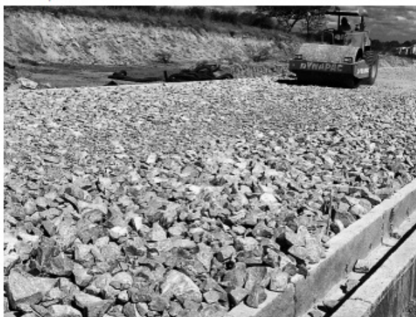
Figura 6 - Rachão ou "pedra de mão" sendo utilizada como base em ferrovia Fonte: Lopes (2017, p. 20).
