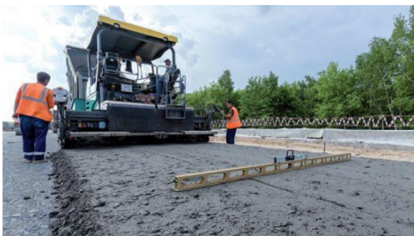
Figura 12 – Fase de aplicação, adensamento, nivelamento e acabamento final da pavimentação de concreto Fonte: ABEDA (2011)
