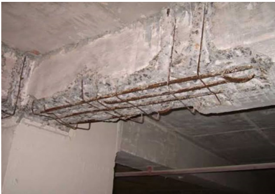
Figura 6 – Concreto desgastado
