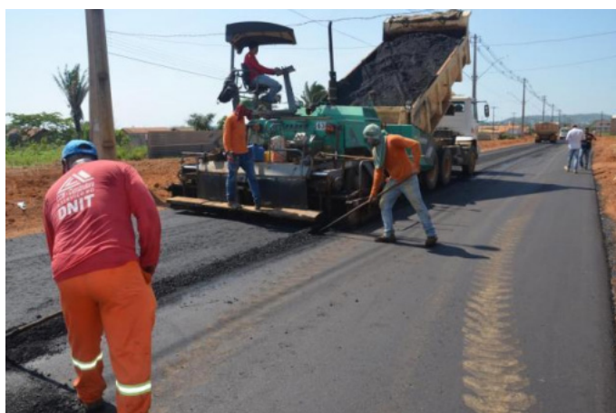
Figura 4 – Implantação de camada do pavimento flexível Fonte: Mapa da Obra (2015)
