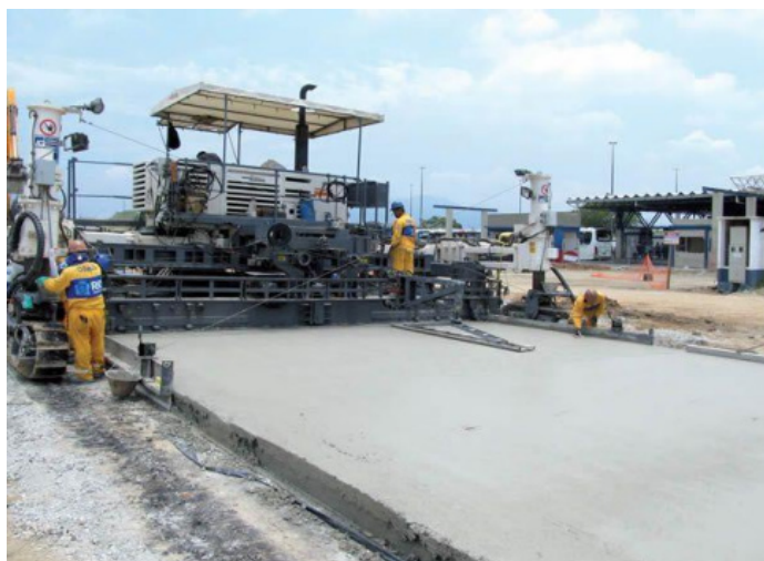
Figura 3 – Implantação de camada do pavimento rígido Fonte: Mapa da Obra (2015)
