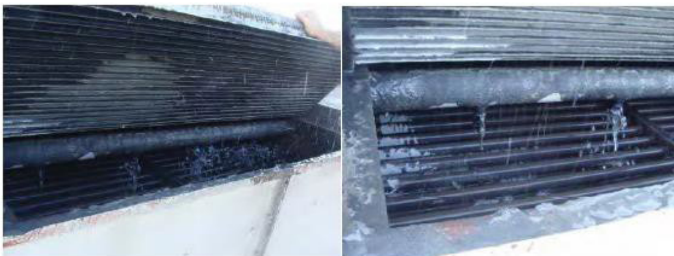
Figura 7 – Bicos aspersores com entupimento
