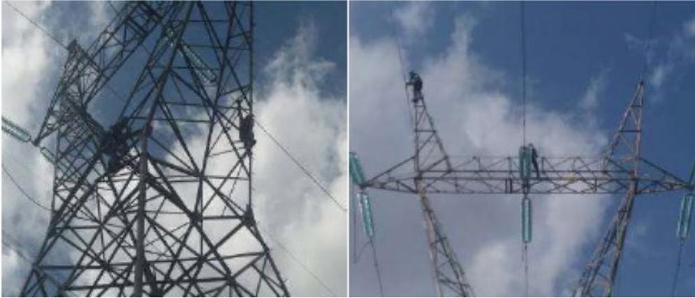
Figura 4 – Execução de atividade em torre de transmissão de 230 kV.
