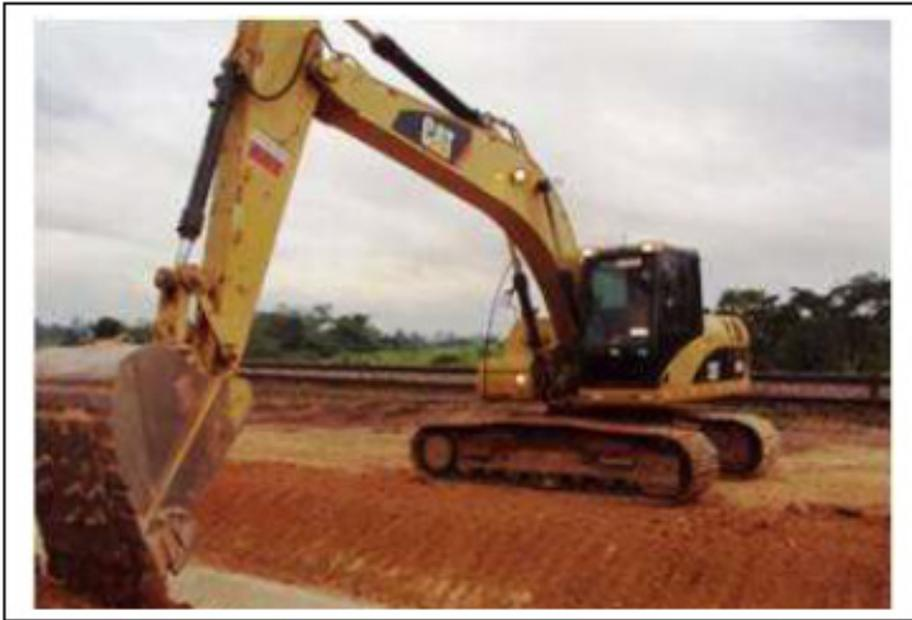
FIGURA 5 - Execução de terraplanagem
