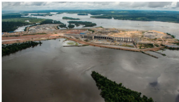
Figura 5 – Represa de Belo monte em construção no rio Xingu. Fonte: Fearnside (2019)
