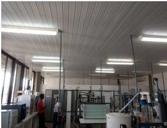
Figura 04 - Visão geral do LPEQ, com ênfase na disposição de tomadas aéreas.
