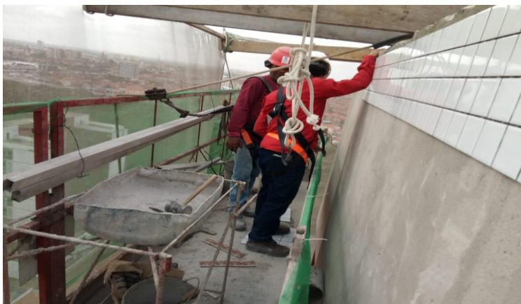
Foto 02 - Trabalhador exercendo trabalho em altura
