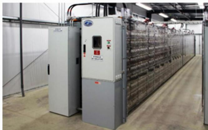
Figura 5 – Ultra Bateria de *Lead-acid*, estação de Lyon Pennsylvania
