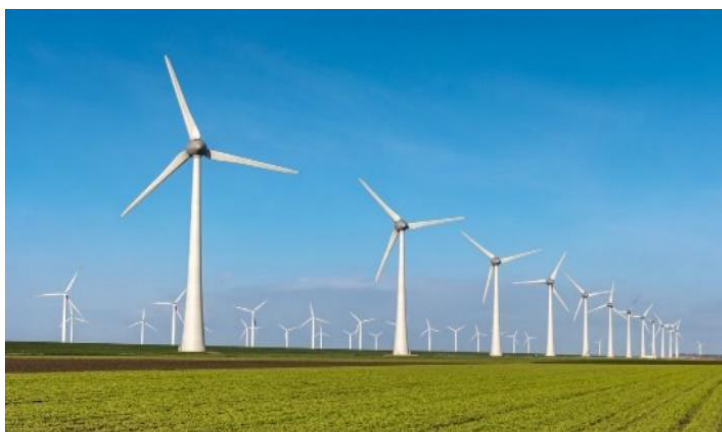
Figura 8: Campo de geradores Eólicos
