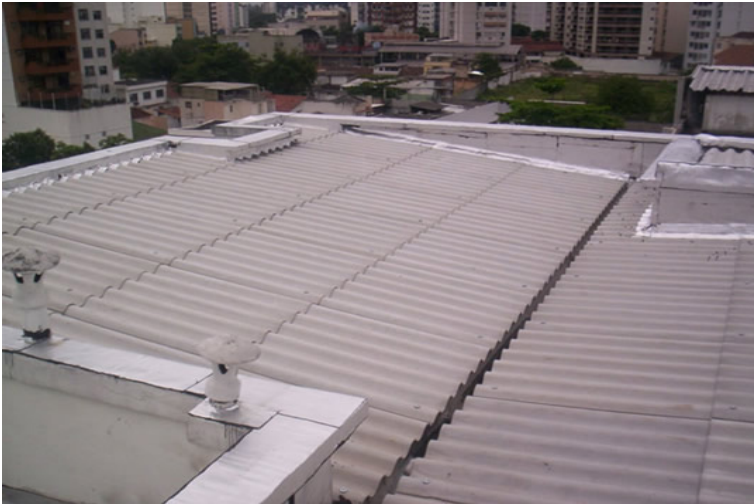
Figura 4: Telhado de Fibrocimento
