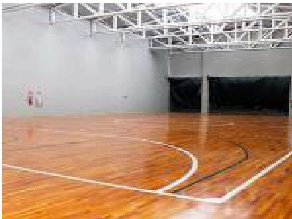
Figura 2 – Piso de madeira
