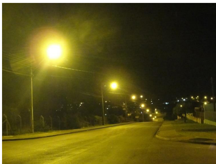
FIGURA 47. Lâmpadas a Vapor de Sódio na Avenida Castelo Branco.
