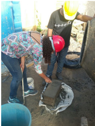
Figura 4: nivelando a da forma do bloco estrutural
