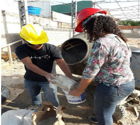
Figura 2: Materiais sendo colocado dentro da betoneira
