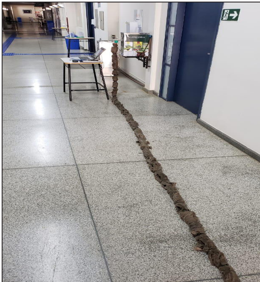
Figura 16. Lã de rocha isolando o sistema.
