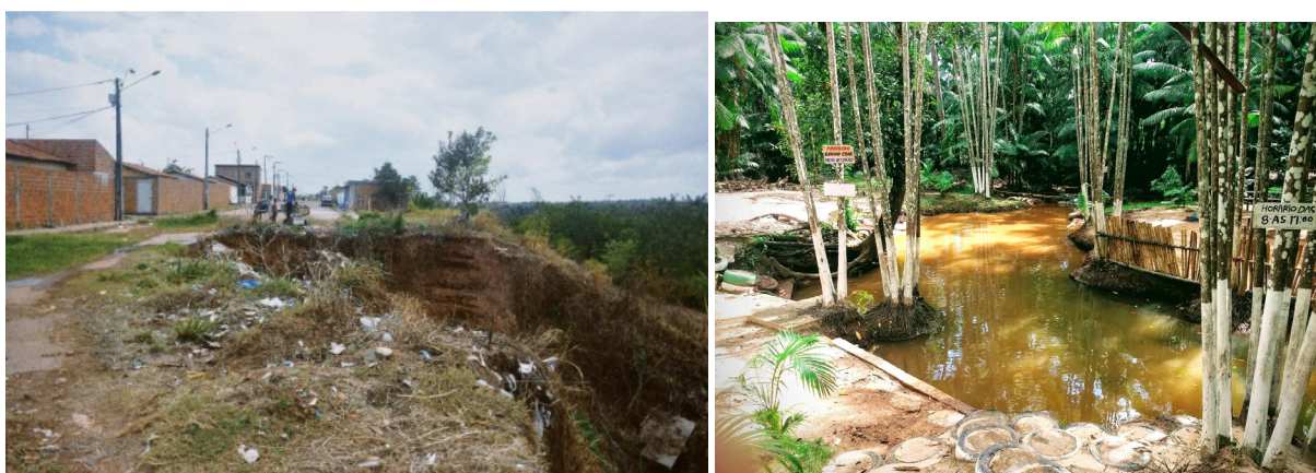
Figuras 3 e 4. Erosão no Residencial MCMV da Ribeira e curso d'água de balneário contaminado por empresa instalada no Distrito Industrial I de São Luís.
