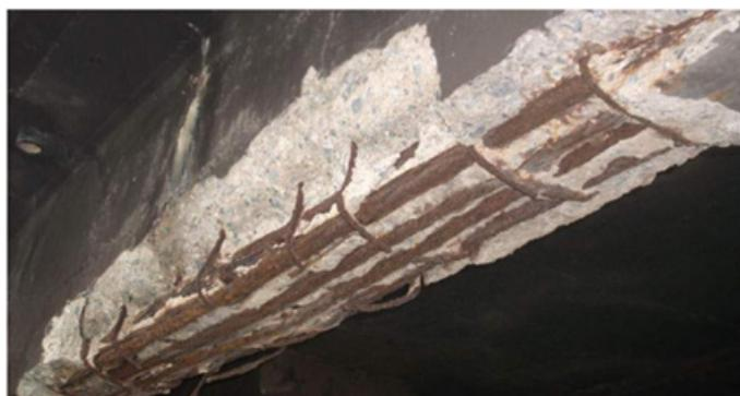
Figura 4. Corrosão em armaduras
