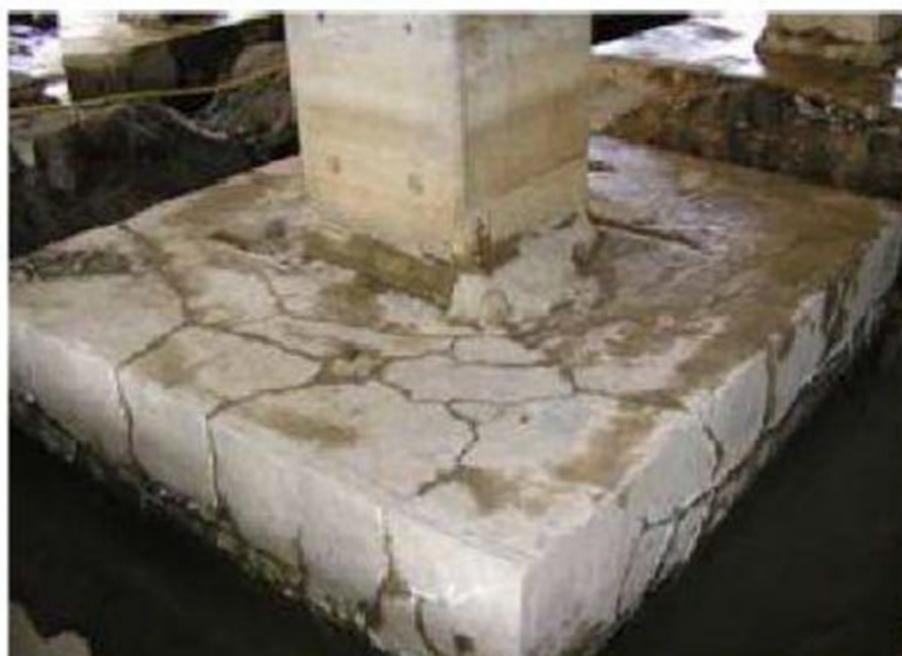
**Figura 1.** Fissuras graves na fundação
