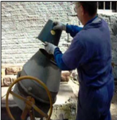
IMAGEM 01: Carregamento manual da betoneira.
