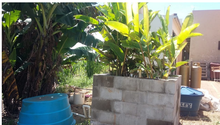
Figura 1 – Sistema alagado construído vertical situado na UTFPR – Campus Londrina Fonte: Autoria própria
