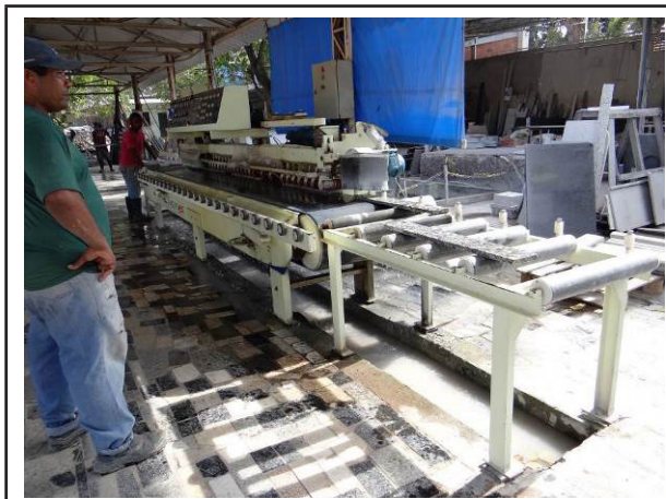
Figura 3 – Escoamento da água sem grade
