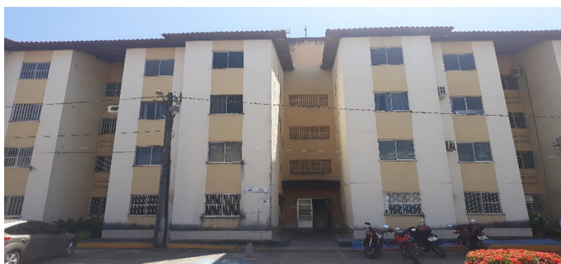
Figura 2 - Estrutura do edifício Fonte: do autor
