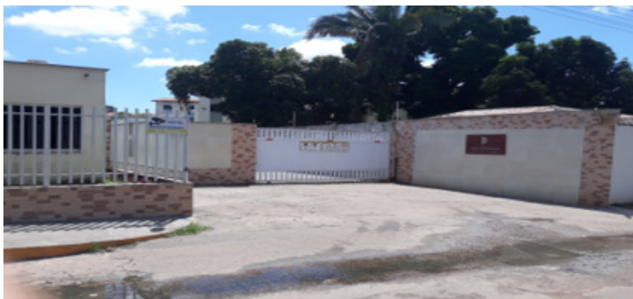
Figura 1 - Portão de acesso a viatura Fonte: do autor
