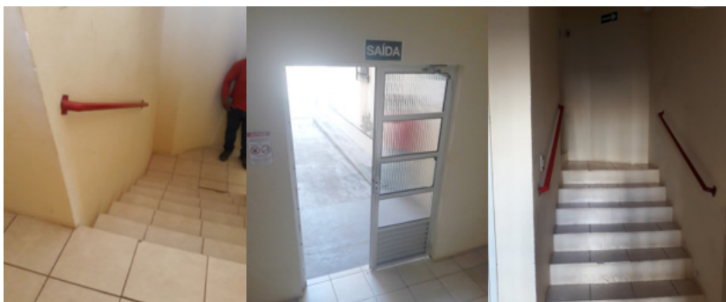
Figura 3 - Acessos, escada e corrimão Fonte: do autor
