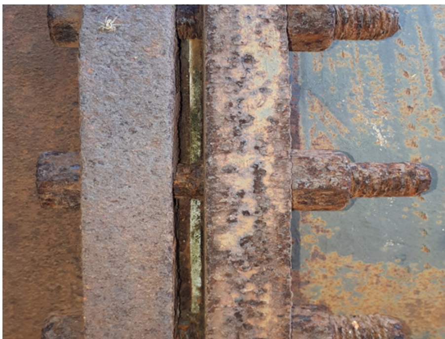
Figura 5 – Redução drástica da massa da seção transversal do elemento de ligação Fonte: O próprio, 2020.
