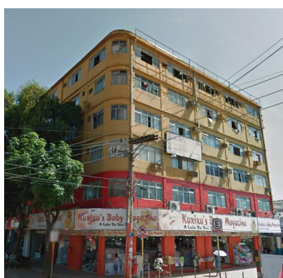
Figura 2 – Visão da fachada lateral do Edifício Luiz Pedro Fonte: Arquivo pessoal
