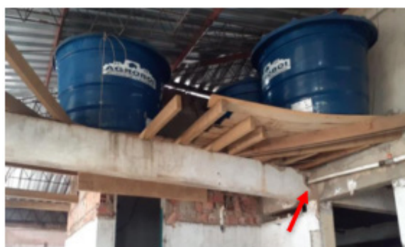
Figura 10 - Viga perfurada com sobrecarga Fonte: Arquivo pessoal
