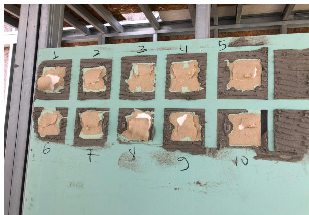
Figura 9 - Ruptura no substrato da chapa RU Fonte : Autores (2019)
