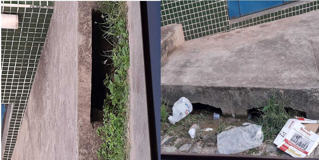
Figura 4- Boca de lobo de guia 01 e boca de lobo combinada 02 Fonte: Acervo do autor, (2020)
