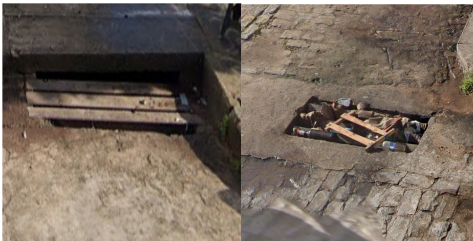
Figura 9- Boca de lobo com grelha 11 e boca de lobo com grelha 12 Fonte: Acervo do autor, (2020)
