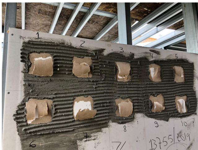
Figura 8 - Ruptura no substrato da chapa ST Fonte : Autores (2019)
