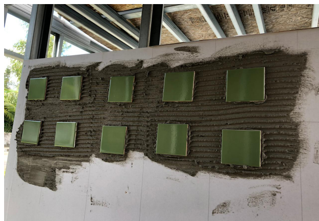
Figura 5 - Placas cerâmicas assentadas sobre a chapa Standard Fonte : Autores (2019)
