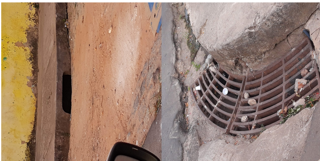
Figura 6- Boca de lobo de guia 05 e boca de lobo com grelha 06 Fonte: Acervo do autor, (2020)
