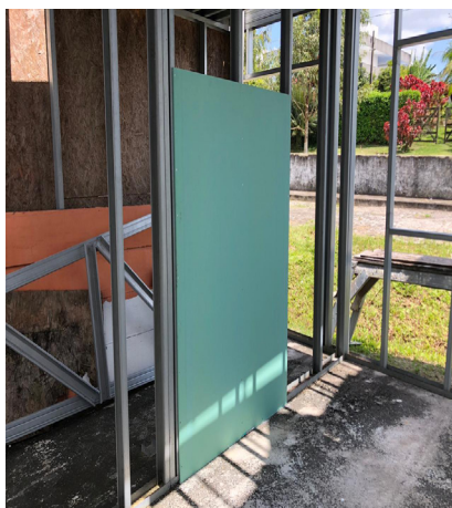
Figura 3 - Chapa de gesso RU fixada sobre a estrutura Fonte : Autores (2020)
