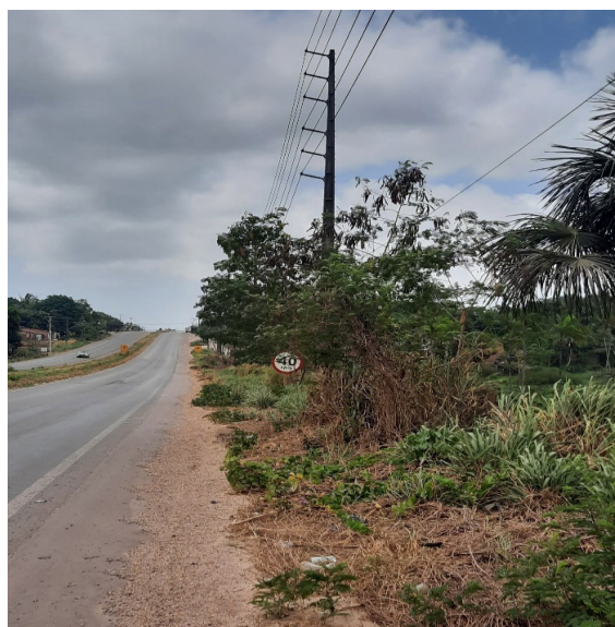
Figura 17: Sinalização coberta pela vegetação Fonte: Autor (2020)
