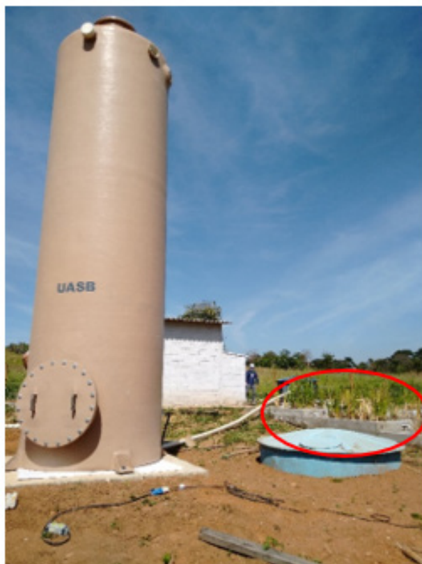
Figura 6 – Sistema de tratamento de esgoto do Campus Aparecida de Goiânia, composto por reator UASB e Wetland (em destaque)
