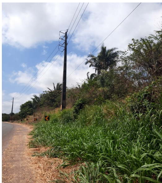
Figura 16: Sinalização em ponto crítico Fonte: Autor (2020)
