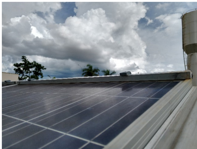
Figura 9 – Perfis de alumínio na borda dos painéis
