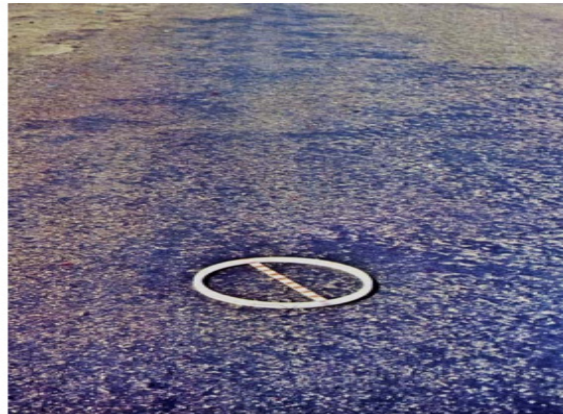
Figura 6: Exsudação Fonte: DNIT (2003a)
