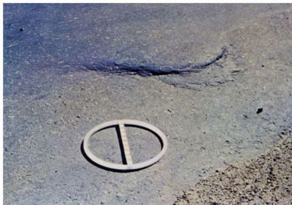
Figura 5: Escorregamento Fonte: DNIT (2003a)
