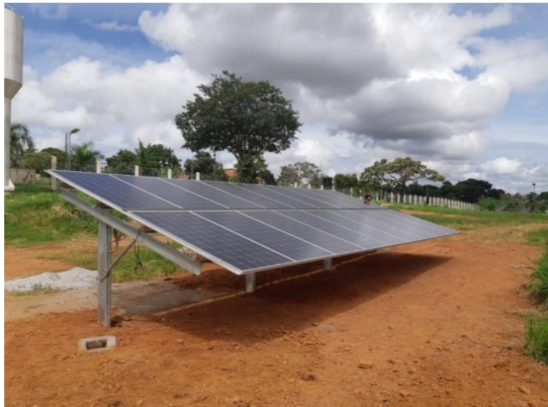
Figura 4 – Estrutura de fixação dos painéis no solo com duas strings de 9 painéis
