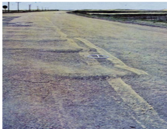
Figura 4: Ondulação Fonte: DNIT (2003a)
