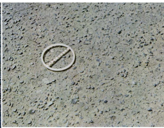
Figura 8: Desgaste Fonte: DNIT (2003a)
