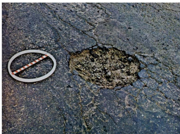
Figura 7: Panela Fonte: DNIT (2003a)
