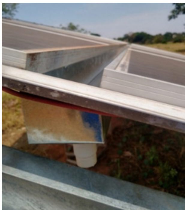
Figura 10 – Calha de coleta da água após arrefecimento
