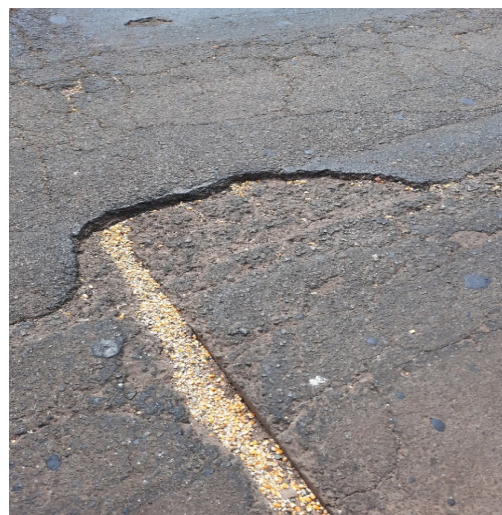
Figura 15: Placa superficial Fonte: Autor (2020)
