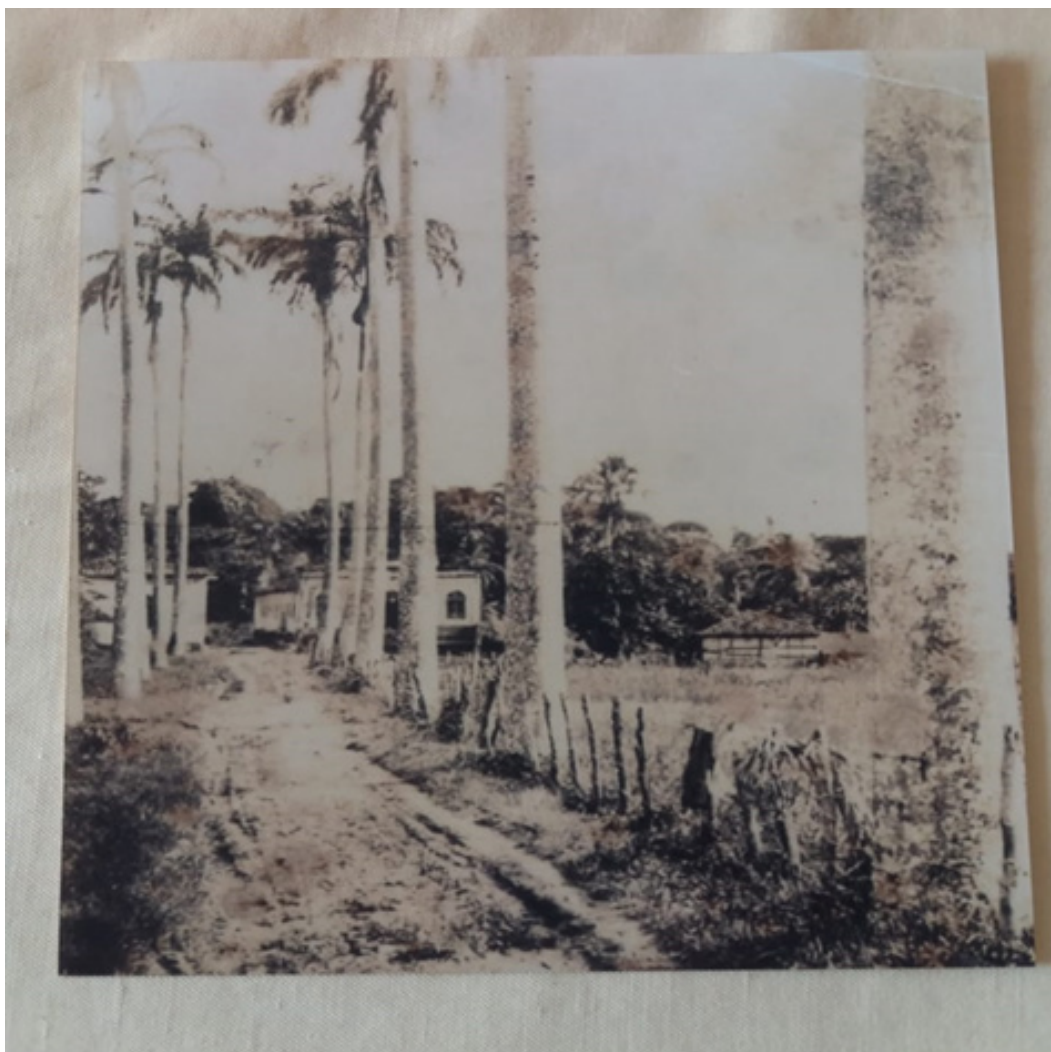
Casarão sede da Quinta no Canto da Fabril (Fonte: Acervo do autor)
