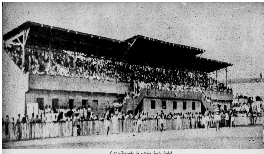
A arquibancada do estádio Santa Isabel
