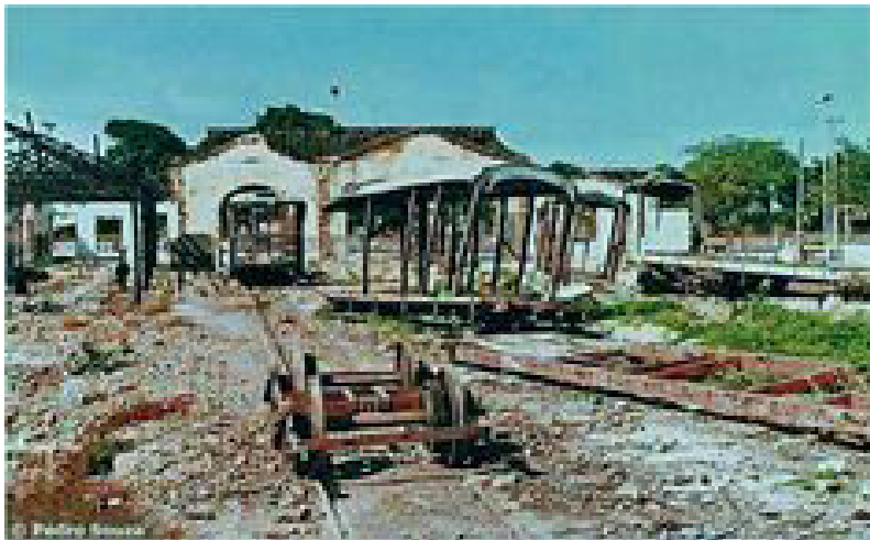
Parte interna da garagem com sucatas de bondes (Fonte: Fotógrafo Pedro Souza)
