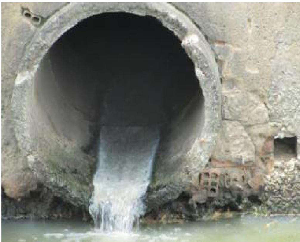
Figura 7: Infiltração em tubulação de rede de drenagem pluvial Derby
