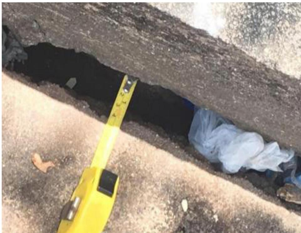
Figura 9: Fissura expressiva na rede de drenagem- Canal da Malária
