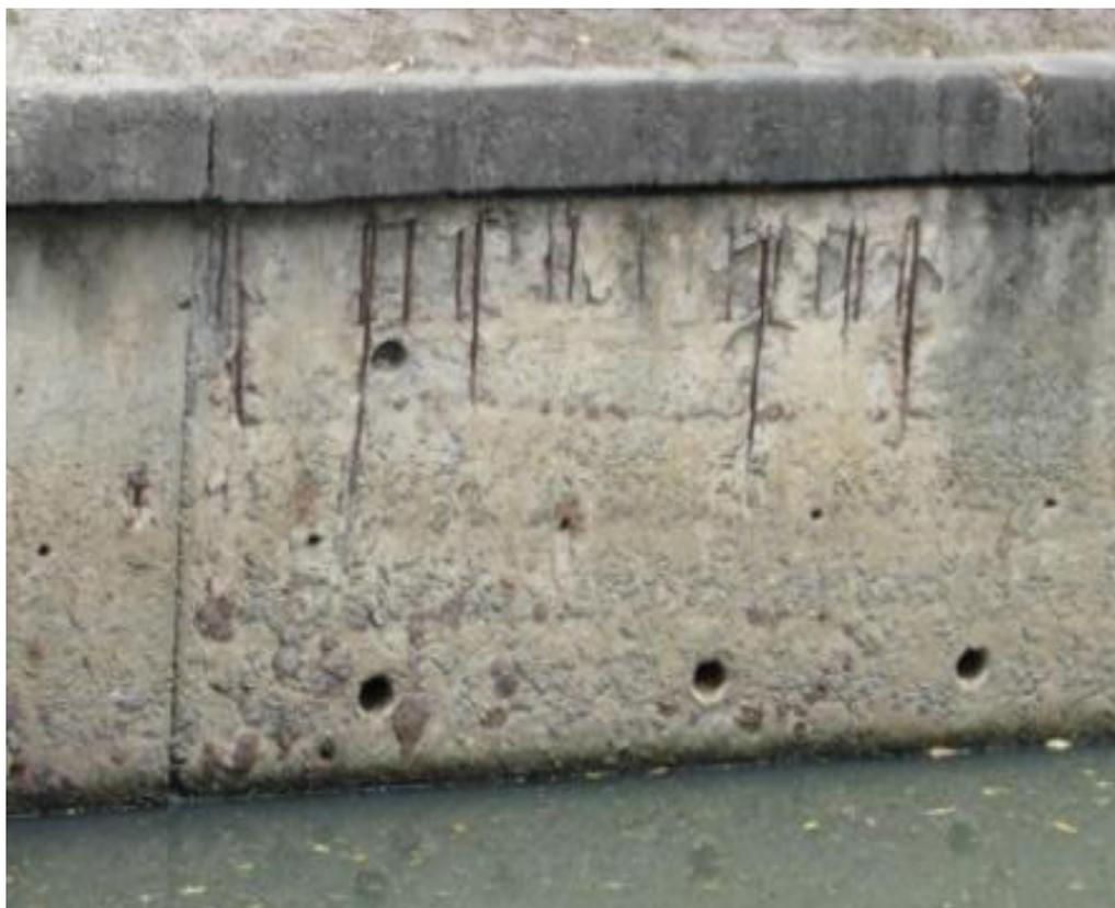
Figura 5: Armadura corroída Canal Derby/Tacaruna
