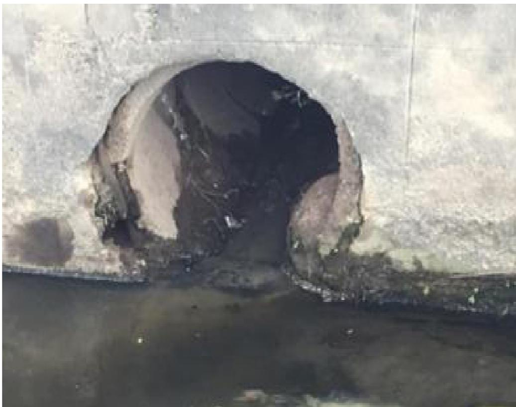
Figura 6: Pequeno início de colapso na tubulação de drenagem- Canal da Malária
