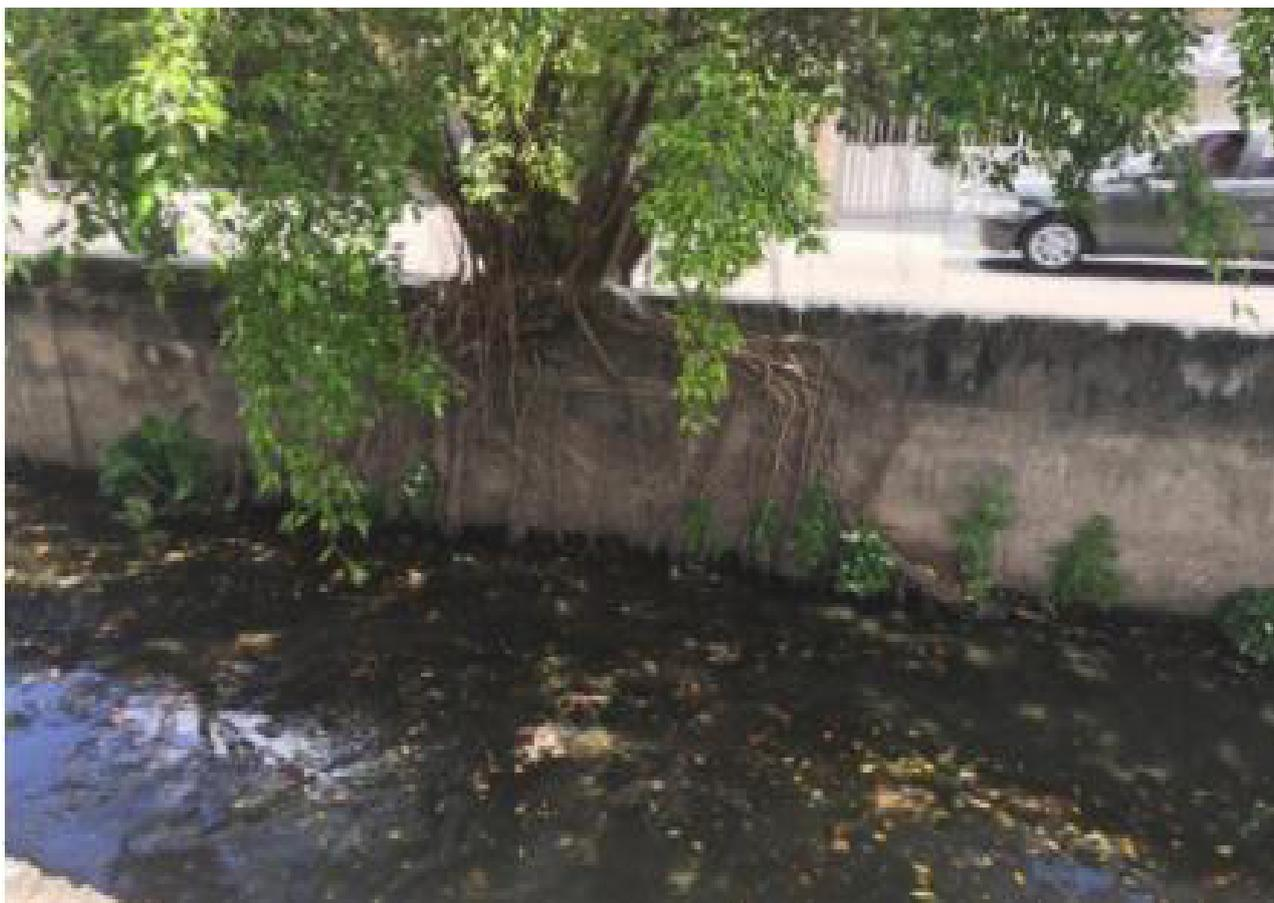
Figura 8: Parede do canal da Malária tomada por raízes
