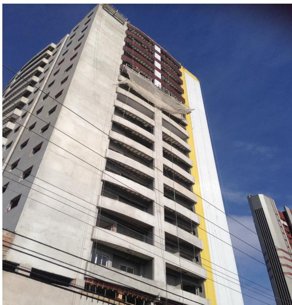
**FIGURA. 1** – Trabalho em altura com rede de proteção
