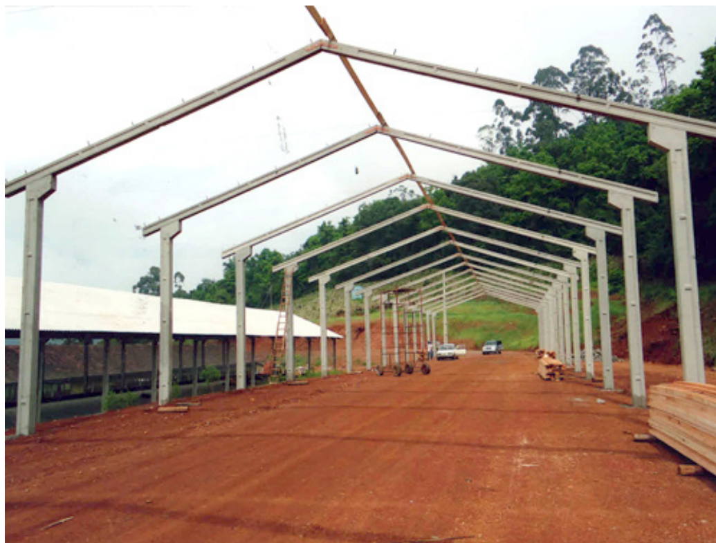
Figura 4. Pavilhão de concreto pré-moldado
