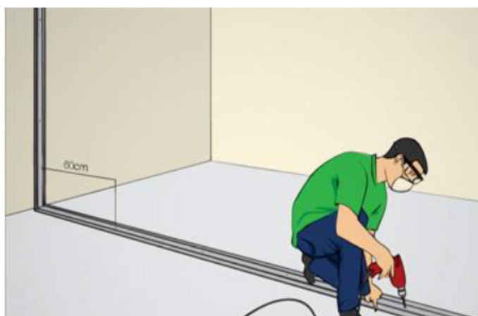
Figura 3 – Instalação das guias
