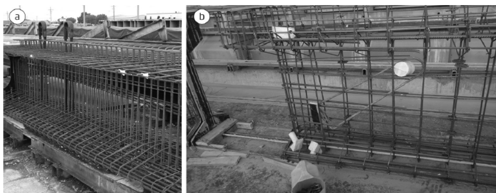
Figura 5: Armadura para montagem
