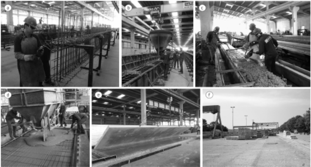
Figura 3: Etapa do processo de execução pré-moldados
