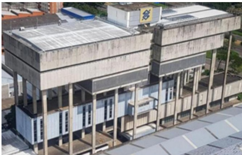
Figura 1 – Exemplo de edificação com pilares esbeltos de concreto armado
