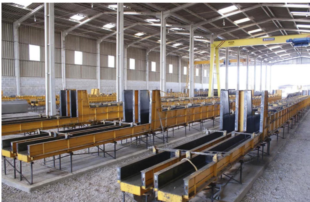
Figura 1: Fábrica de estruturas de concreto pré-moldado
