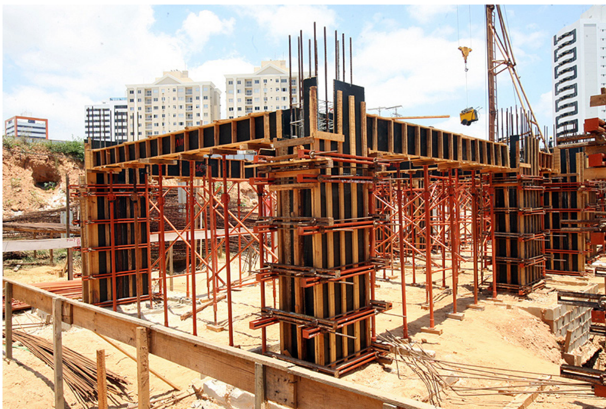
Figura 1. Estrutura moldada in loco
