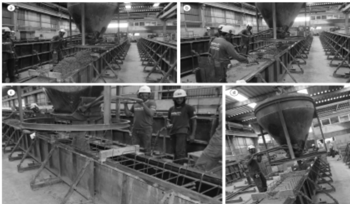
Figura 7: Processo de concretagem
