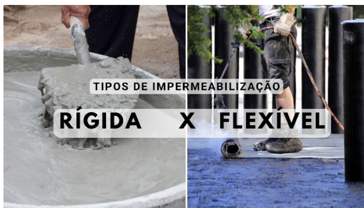
Figura 3. Tipos de Impermeabilização
