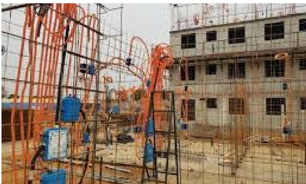
Figura 7: Kit de eletrodutos já instalados nas armações
