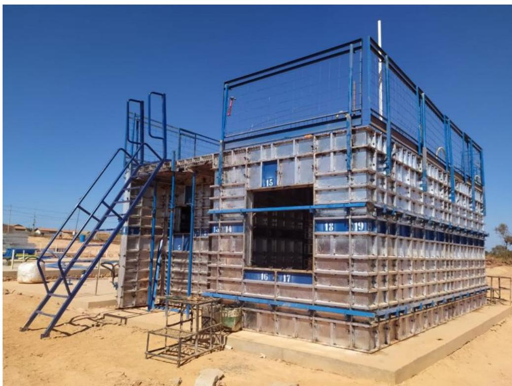
Figura 6: Forma para parede de concreto
