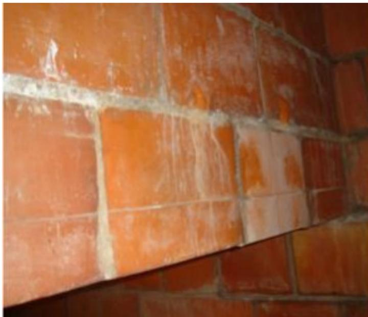
Figura 5 - Eflorescência na alvenaria estrutural
