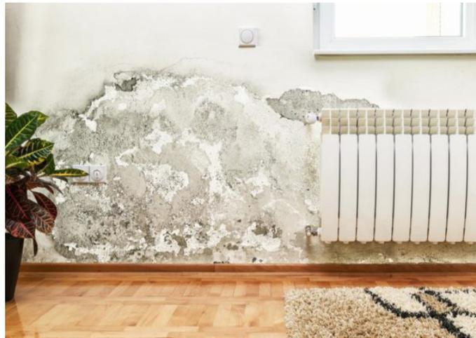
**Figura 4** – Infiltração por capilaridade
