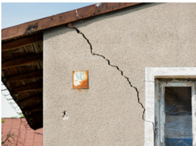
Figura 9 - Fissuras mapeadas.
