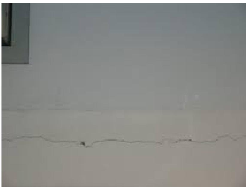
Figura 7 - Fissuras Horizontais
