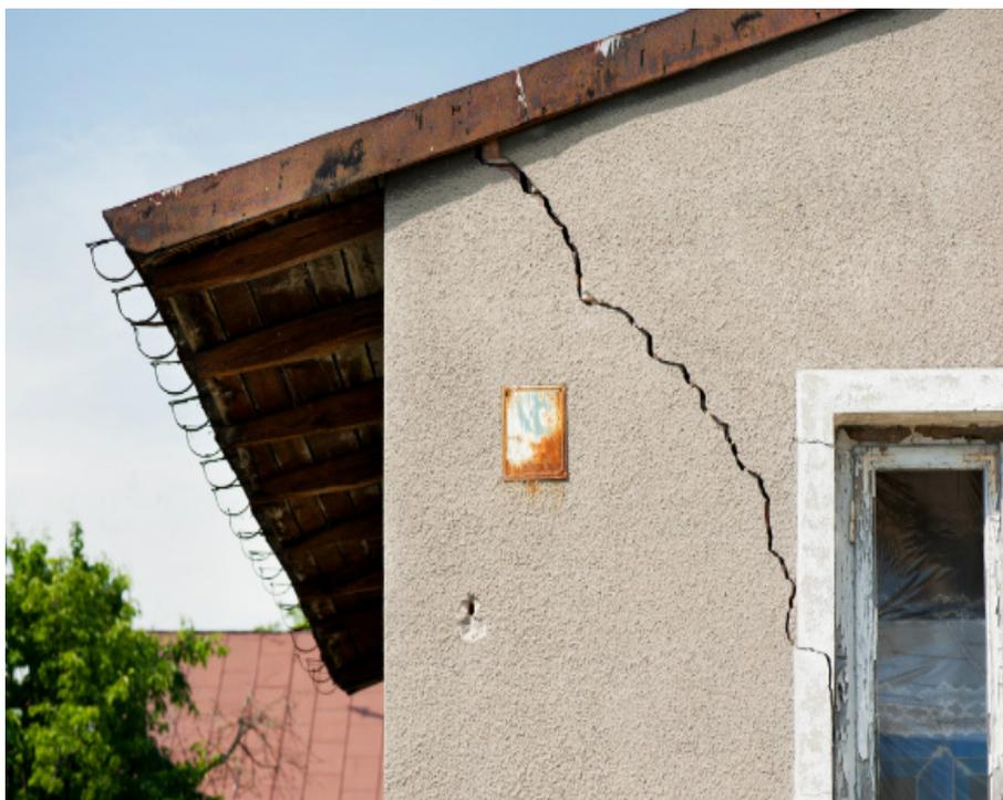
Figura 8 -Fissuras verticais.
