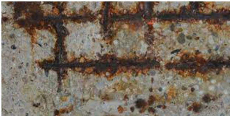
**Figura 3** – Infiltração nas armaduras
