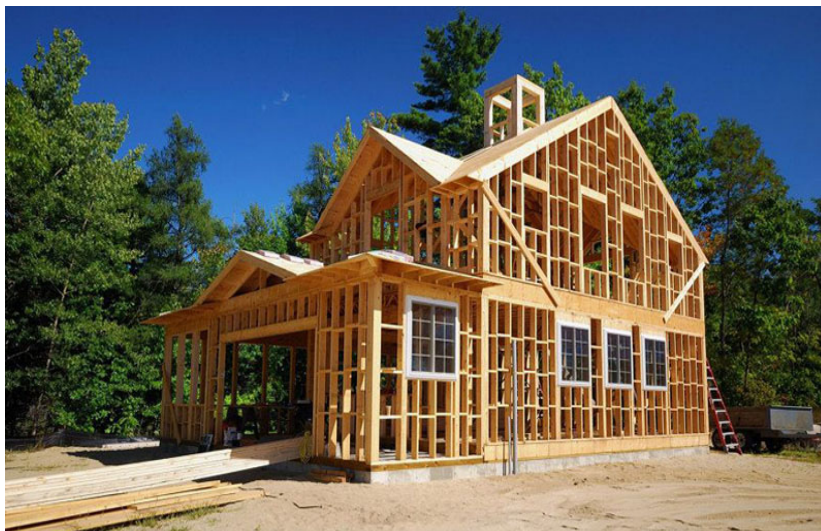
Figura 2. Casa em estrutura de madeira (Wood Frame)
