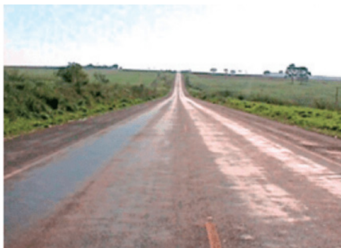
Figura 9. Exsudação do pavimento flexível Fonte: Inova Civil (2019)
