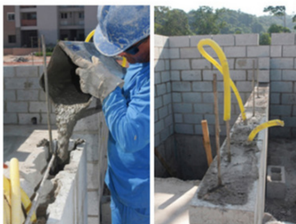
Figura 2. Grauteamento da alvenaria
