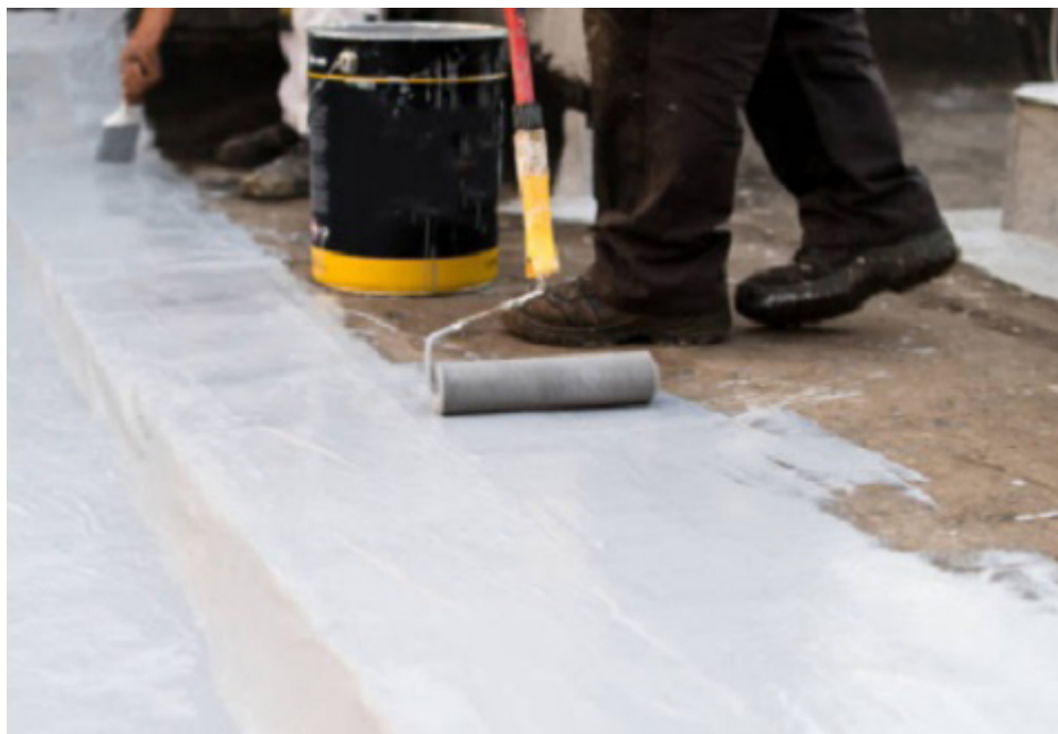
Figura 3. Impermeabilização da laje
