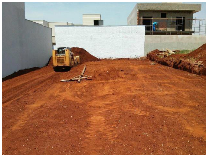
Figura 3. Limpeza do terreno.
