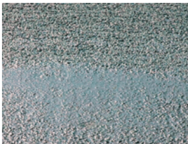
Figura 9. Exsudação do pavimento flexível Fonte: Inova Civil (2019)
