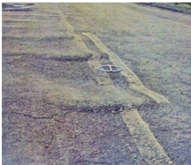
Figura 7. Ondulação no pavimento flexível Fonte: DNIT (005/2003)
