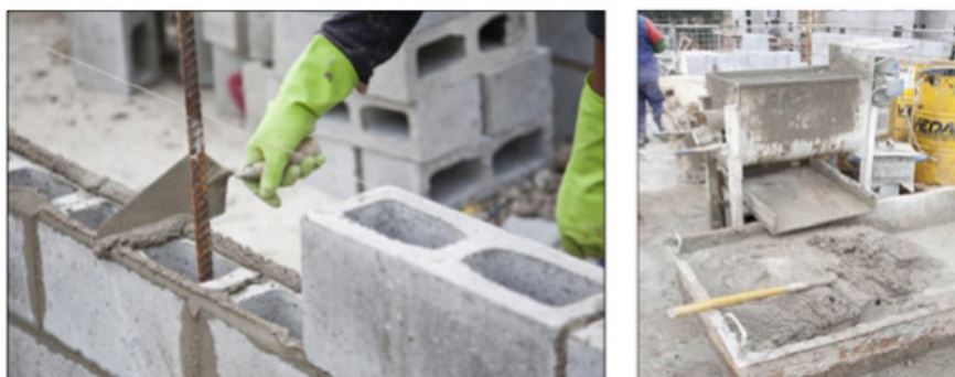
Figura 1. Argamassa de assentamento
