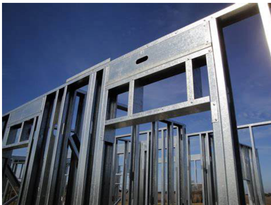
Figura 1. Estrutura com perfis de aço galvanizado
