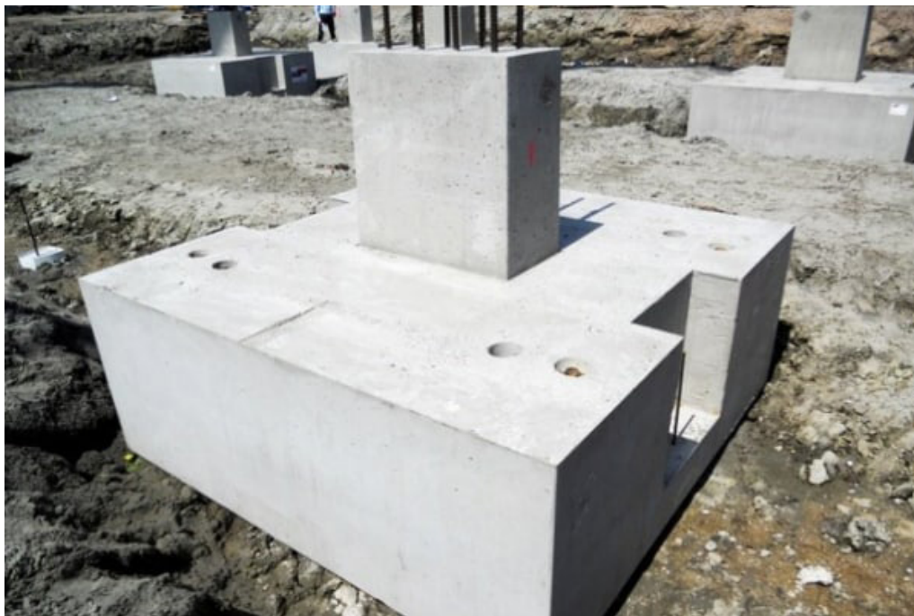
Figura 5. Bloco de Fundação
