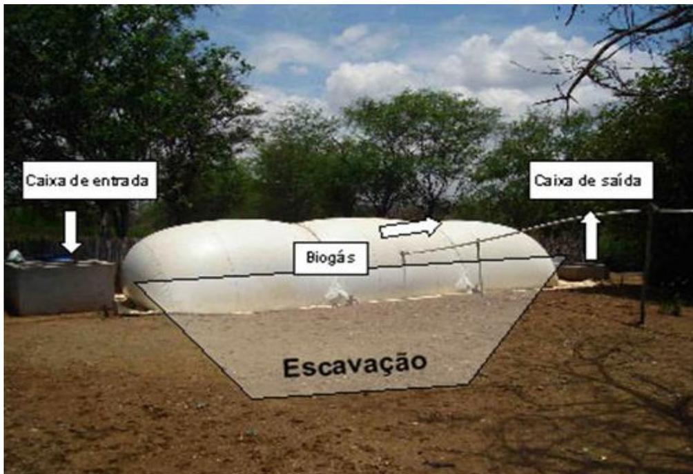
**Figura 2.** Biodigestor de modelo canadense
