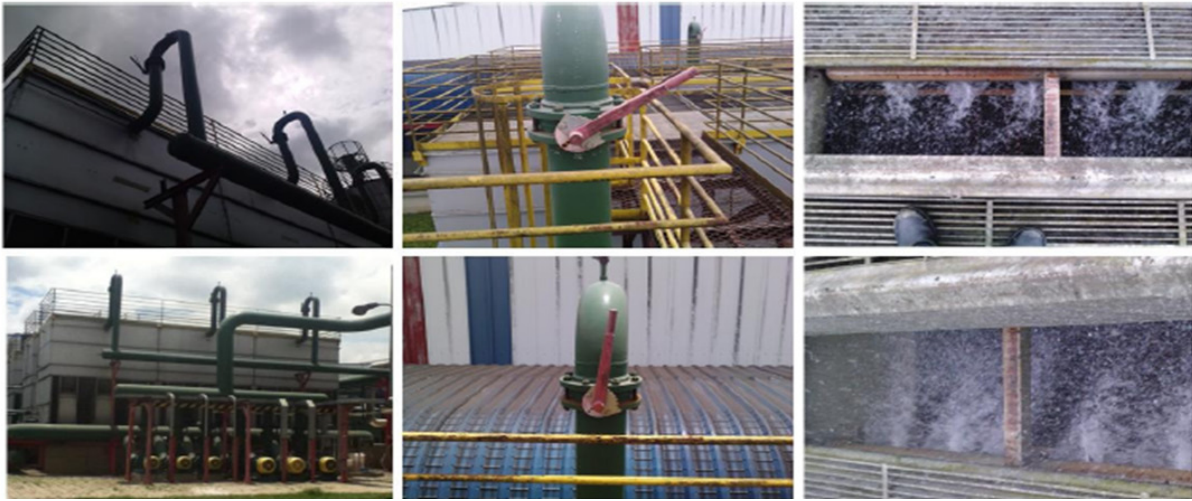
Figura 7. Boias e no ladrão para aumentar a eficiência das torres de resfriamento
