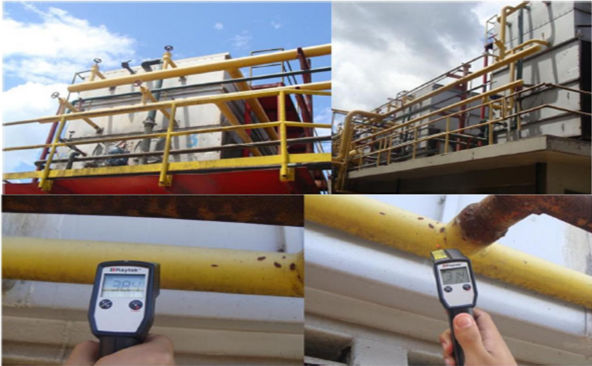
Figura 6. Condensadores evaporativos operando em paralelo com diferentes perdas de carga
