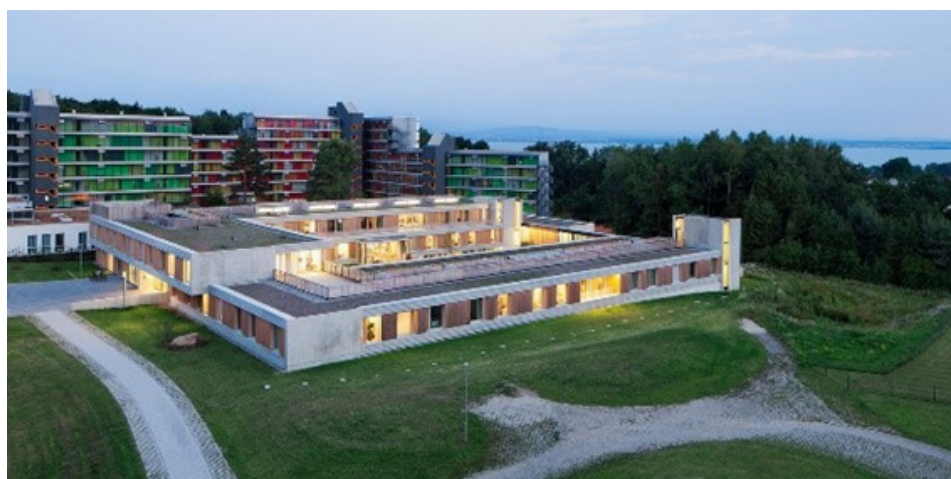
Figura 2. Centro de Reabilitação Psiquiátrico Friendrichshafen – Vista Geral
