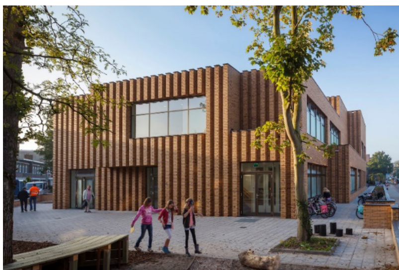
Figura 1. Fachada da Escola Waalsdorp
