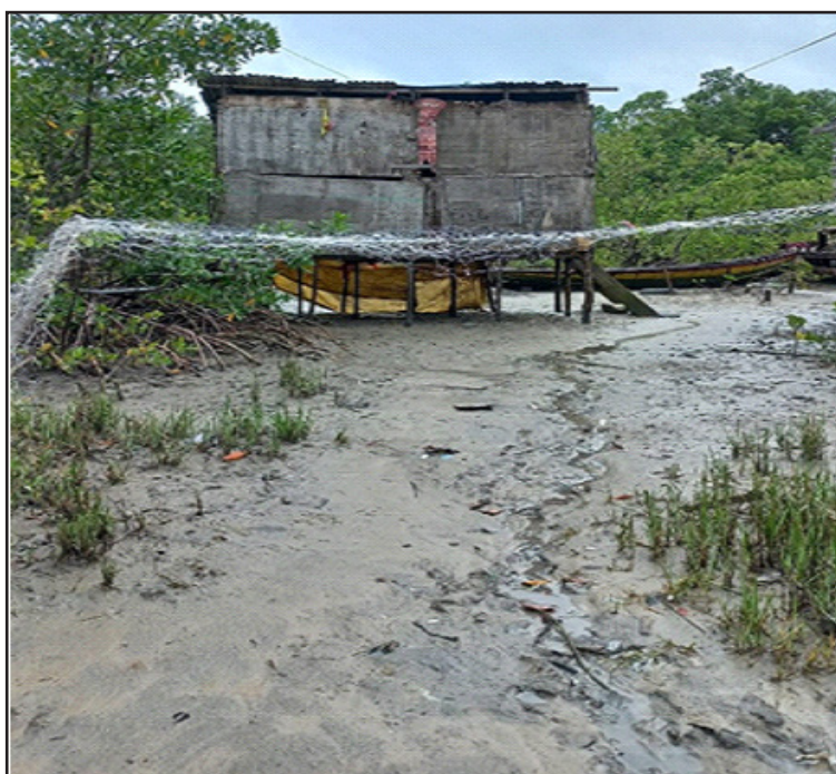
Figura 6. Esgoto de pias despejados no mangue
