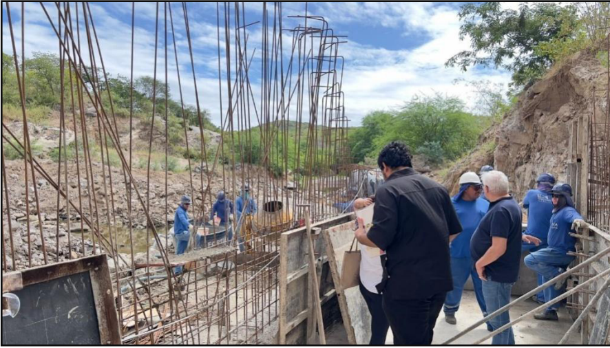
Figura 6. Visita à parte interna da Barragem de Porcos
