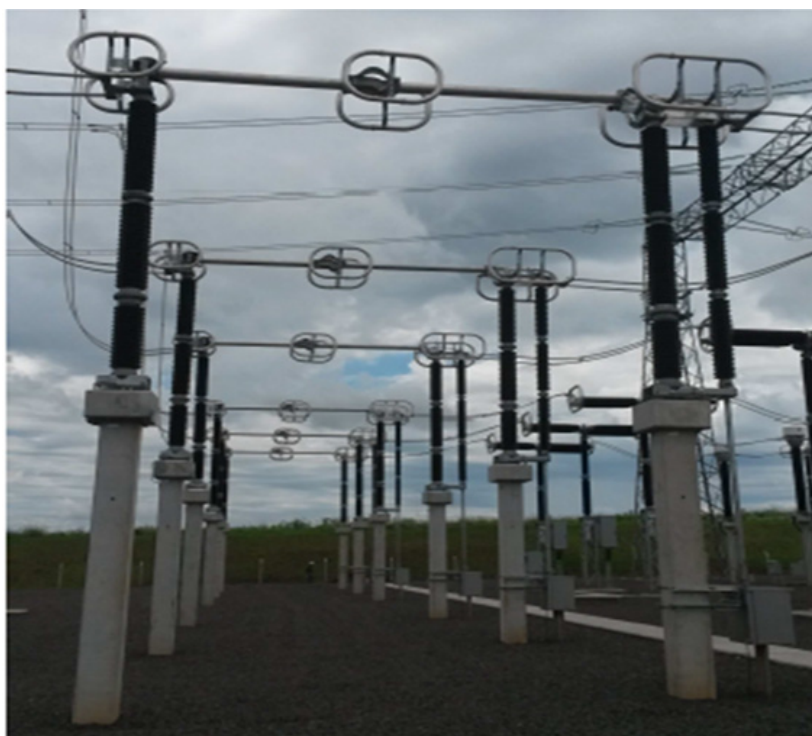
Figura 6. 230kV Chave seccionadora trifásica de 525kv.
