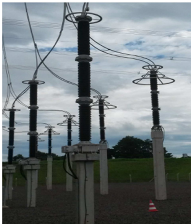
Figura 5. 230kV Transformador de corrente 525kV.
