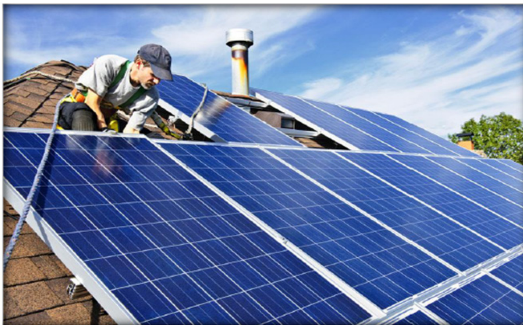
Figura 3. Painel fotovoltaico sendo montado
