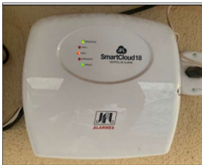
Figura 3. Central de Monitoramento
