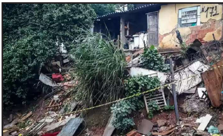
Figura 3. Desabamento de casa Vila Leonin
