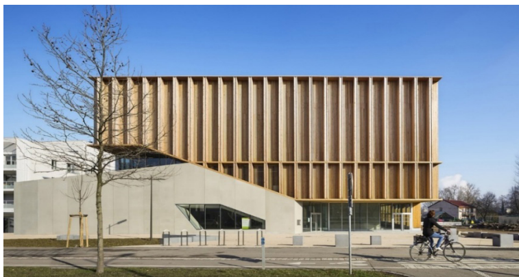
Figura 2. Fachada do Centro esportivo Neudorf.
