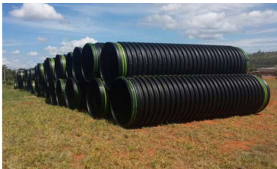
Figura 3. Armazenamento de tubo PEAD
