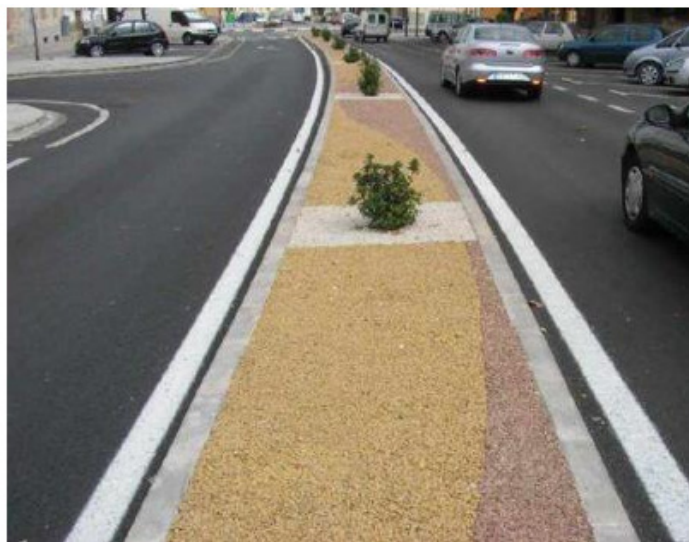
Figura 4. Pavimento permeável monolítico
