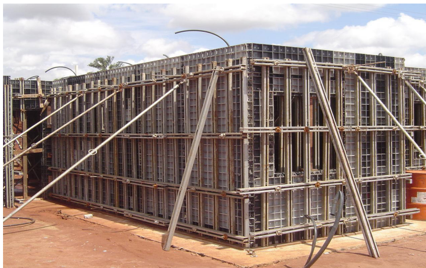
Figura 1. Construção de uma casa pelo método de parede de concreto
