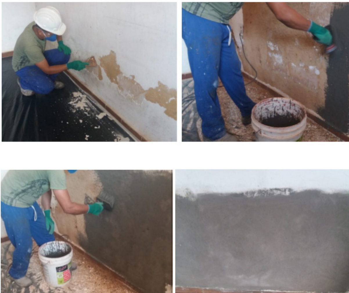
Figuras 4, 5, 6 e 7: aplicação de impermeabilizante
