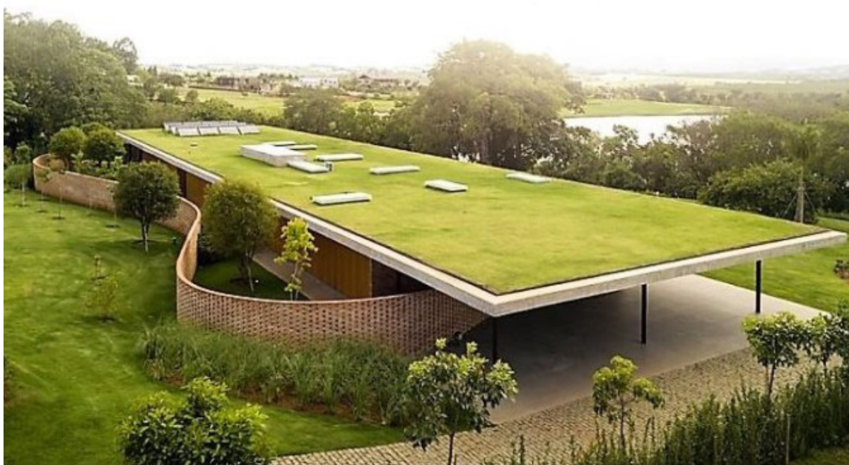
Figura 4. Utilização do telhado verde.
