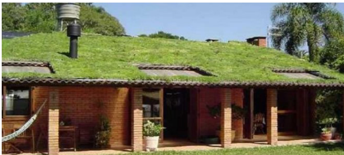
Figura 3. Aplicação da telha ecológica na cobertura de uma Residência.
