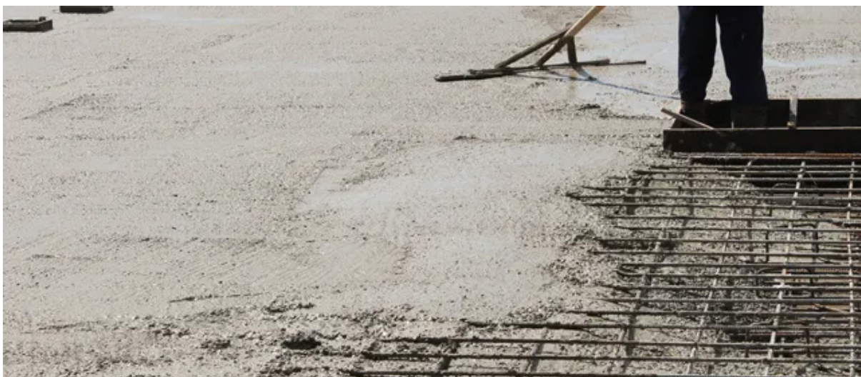
Figura 2. Pavimentos de Concreto
