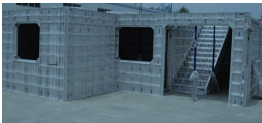
Figura 3. Formas em preparação para concretagem.
