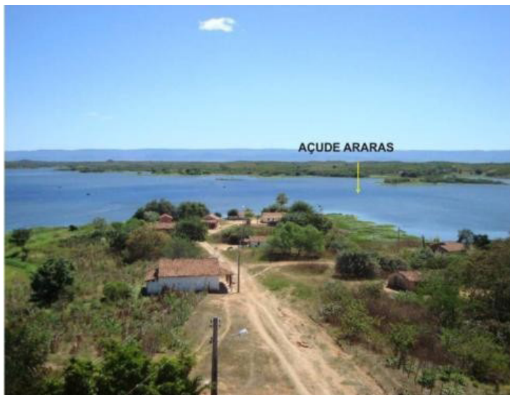
Figura 60 – Vista panorâmica de parte do açude Araras porção nordeste da área de estudo Fonte: Acervo do estágio de Ipueiras.
