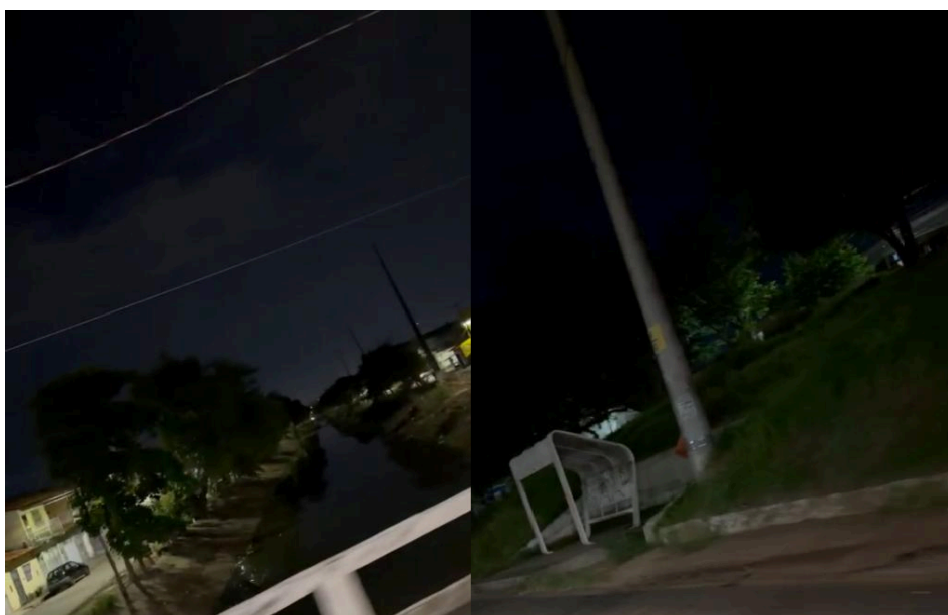
Figura 1 – Área com vala a céu aberto e ausência de saneamento básico adequado em São Luís. Figura 2 – Parada de ônibus com ausência de iluminação pública adequada em São Luís -MA
