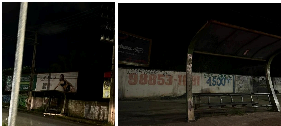
Figura 1 – Iluminação pública insuficiente em via urbana de São Luís/MA
