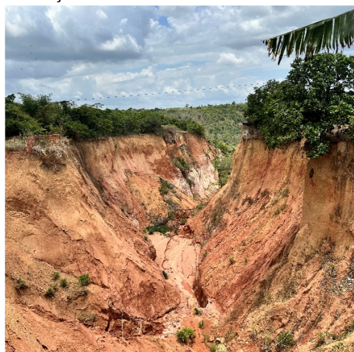
Figura 6: degradação do solo por meio da voçoroca
